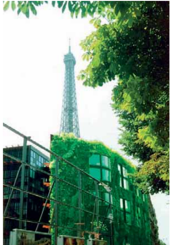
Foto: Begrünte Fassade
