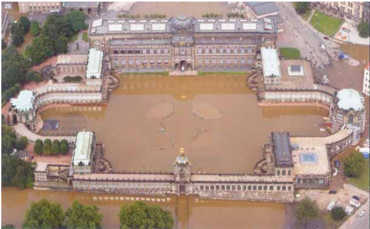
Foto: Hochwasser in Dresden 2003 (Stadt Dresden)
