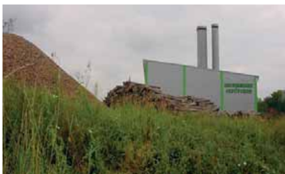
Foto: Biothermie (Stadt Altötting)
